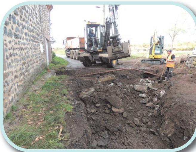
l'engagement du Syndicat départemental d'énergie, a préféré enterrer les réseaux et étendre sur l'ensemble des rues du village la réfection de la chaussée. Malgré des déboires et mauvaises surprises dus aux écoulements souterrains et aux affleurements de basalte, le chantier avance et devrait s'achever d'ici la fin de l'année. Restera au SEMEV de parachever les connexions électriques et l'éclairage public, et aux opérateurs Orange et SFR la connexion téléphonique.
